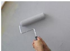
Graphenstone está hecho con una base de cal pura, pero mezclada con grafeno. Tal combinación hace que esta pintura pueda mejorar la regulación térmica de los edificios. Incorpora una red hexagonal de átomos de carbono (de un átomo de espesor). Esto es importante, porque reduce las necesidades de climatización. <http://blog.is-arquitectura.es>. Texto y fotos Blog de arquitectura.es. 2 junio, 2017.
